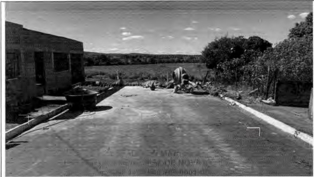
Foto 1. Vista do acesso ao imóvel.
